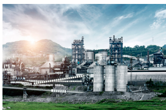
Stavebné hmoty preprava cementu potrebný tlak 4 bar
